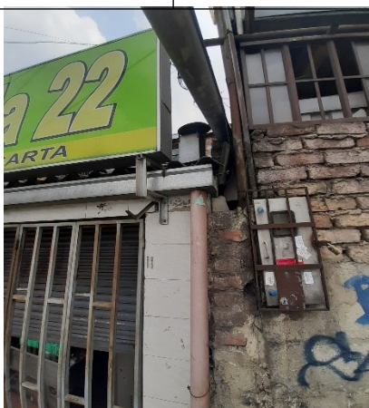
Foto No. 5 ducto
